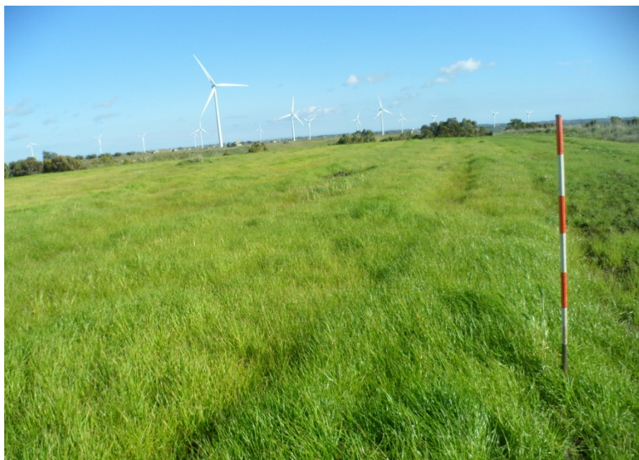
Fig. 19- Foto sito di installazione aerogeneratore F6
