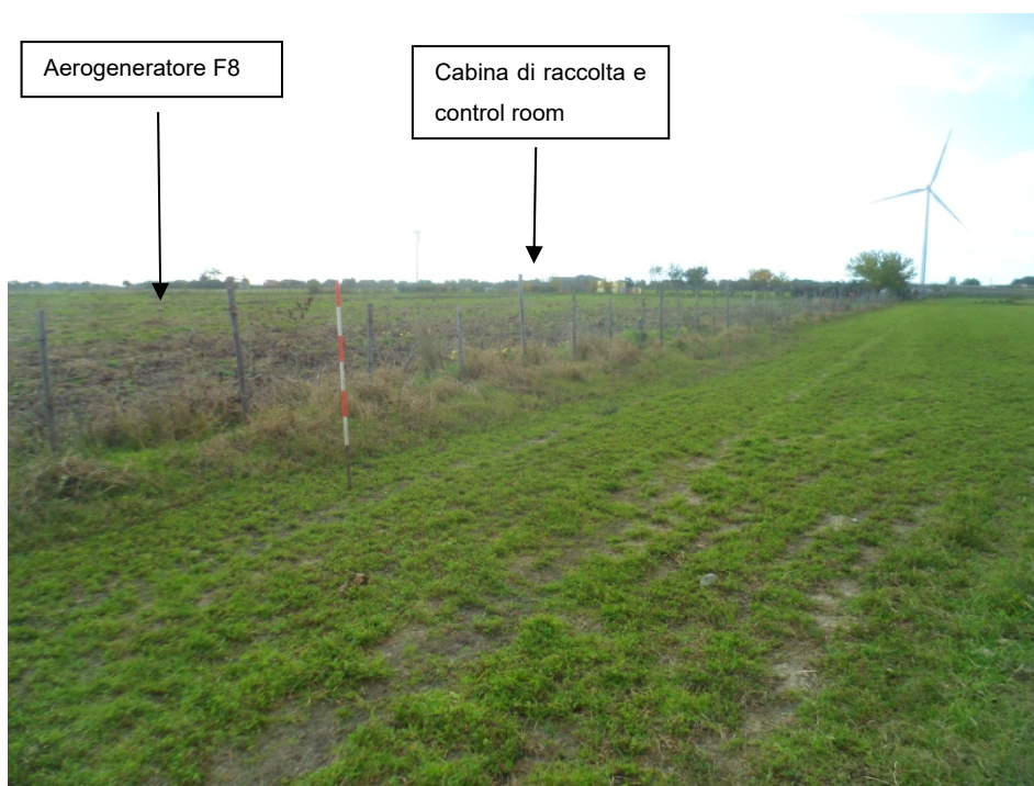
Fig. 21- Foto sito di installazione aerogeneratore F8, cabina di raccolta e control room
