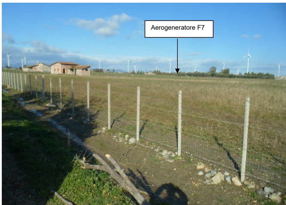
Fig. 20- Foto sito di installazione aerogeneratore F7
