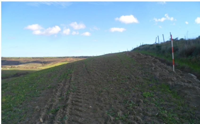
Fig. 14- Foto sito di installazione aerogeneratore F1
