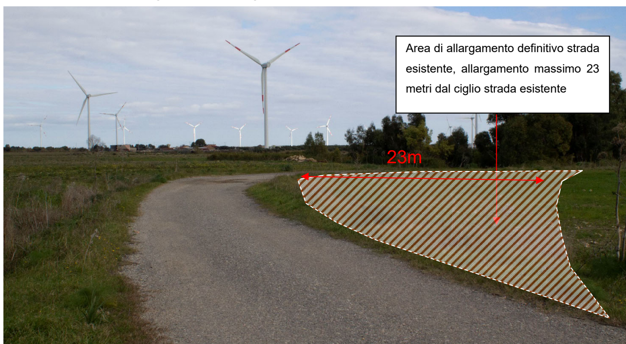
Fig.35-Foto n.3 di figura n.32 Area di allargamento definitivo della strada esistente
