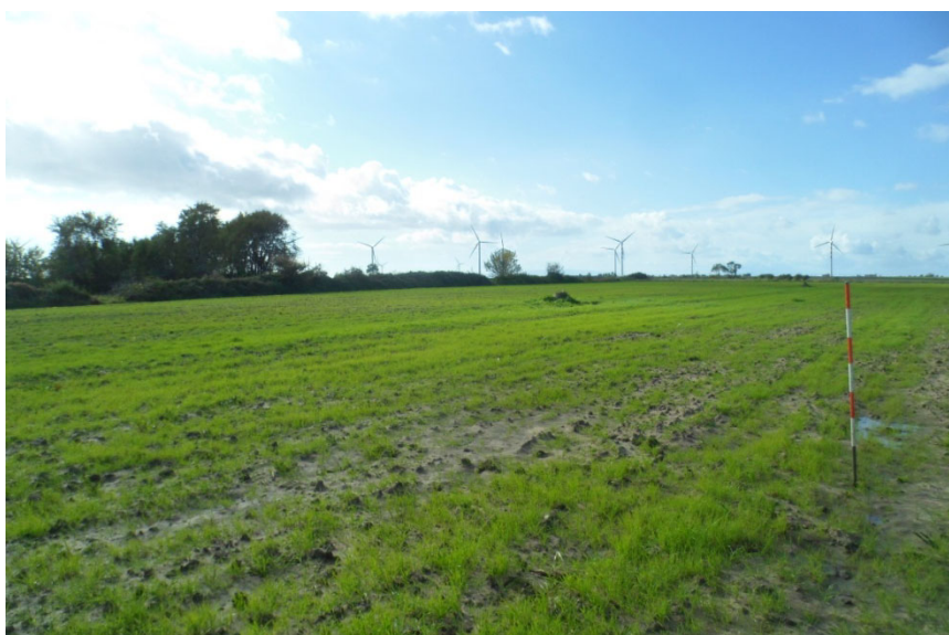
Fig. 16- Foto sito di installazione aerogeneratore F3
