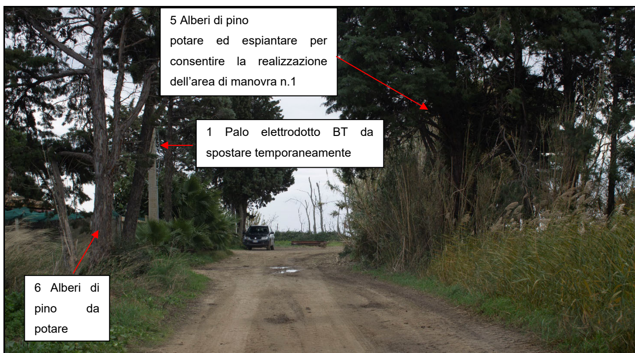
Fig.47-Foto n.2 di figura n.45 Area di manovra definitiva e interferenza con elettrodotto BT
