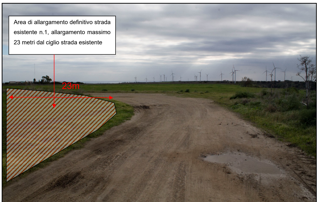
Fig.42-Foto n.1 di figura n.41 Area di allargamento definitivo della strada esistente
