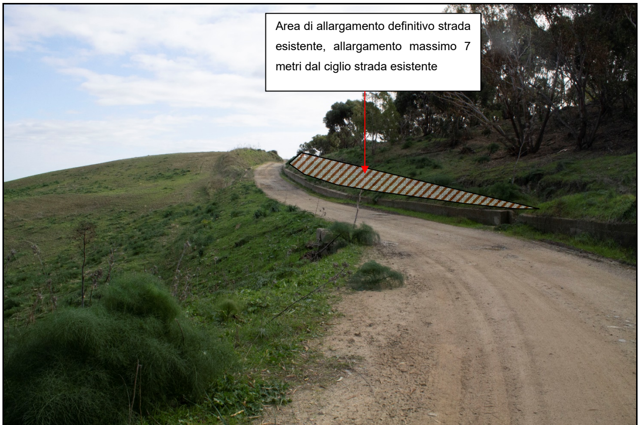
Fig.38-Foto n.1 di figura n.36 Area di allargamento definitivo della strada esistente
