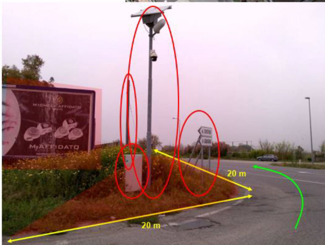
Fig.26-Rimozione ostacoli ed allargamenti sede viaria
