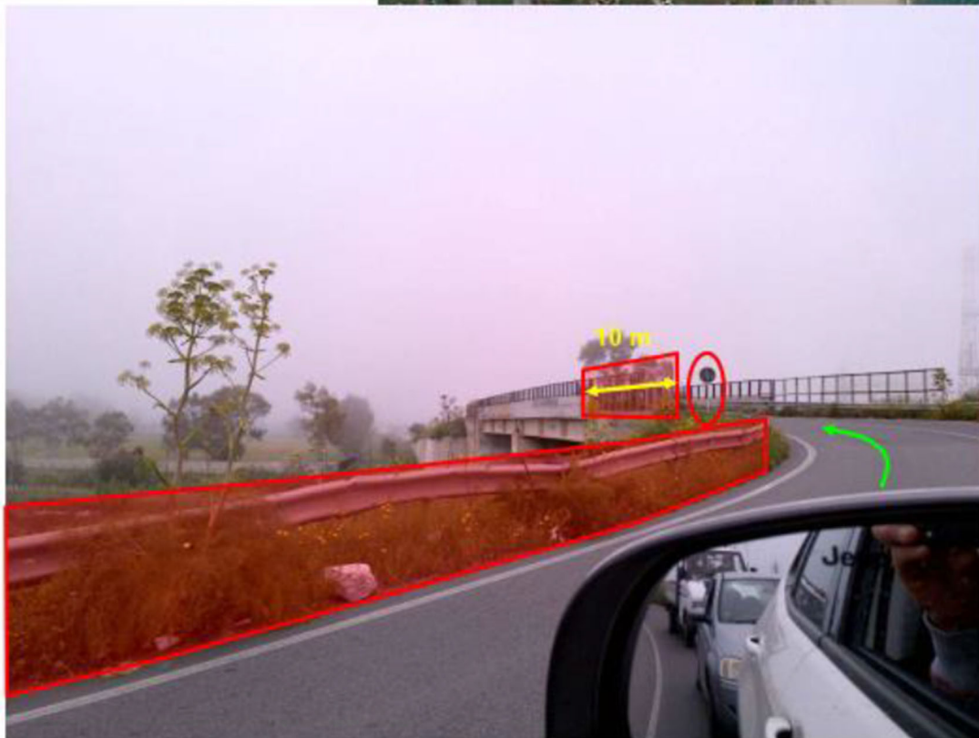
Fig.24-Rimozione barriere ponte
