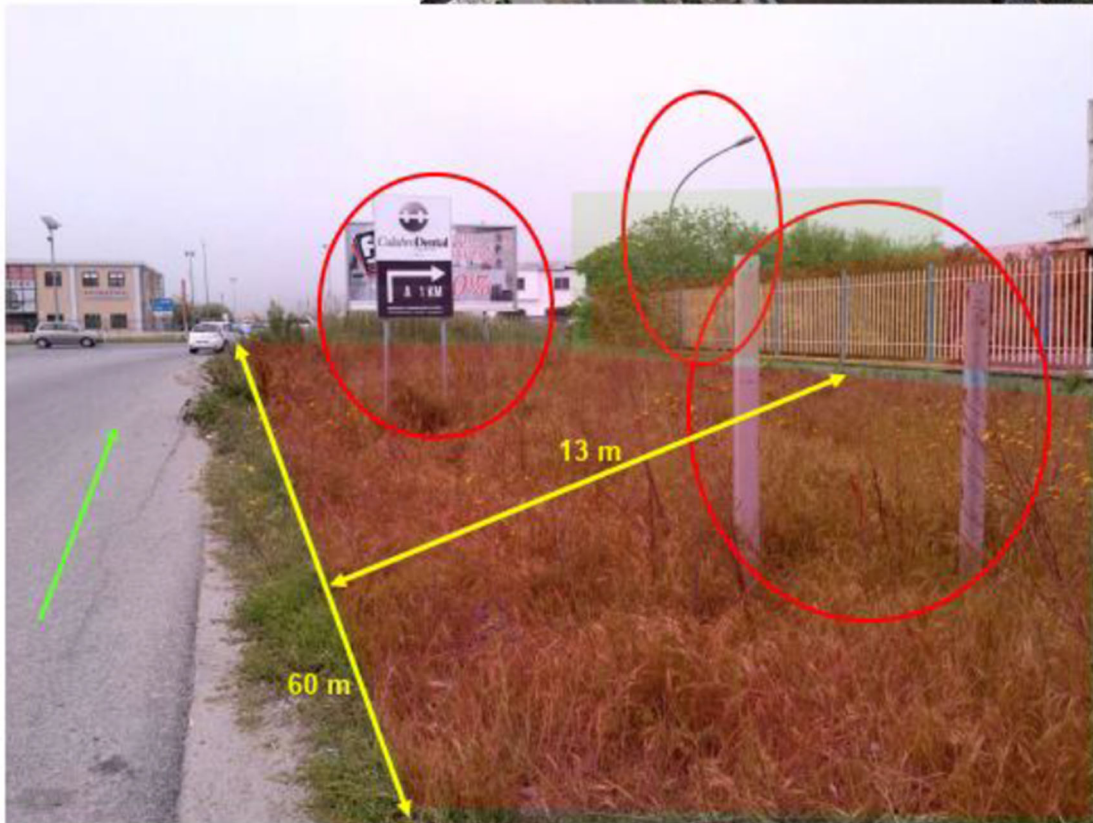
Fig.25-Rimozione ostacoli ed allargamenti sede viaria
