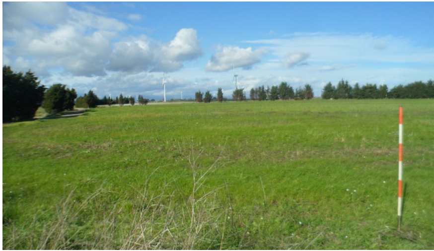
Fig. 17- Foto sito di installazione aerogeneratore F4
