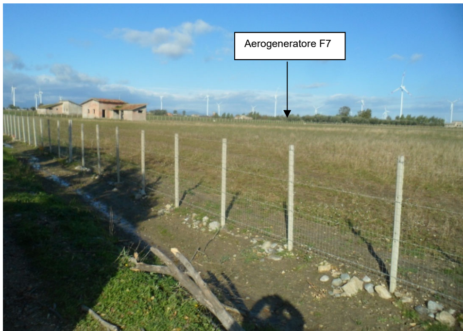
Fig. 20- Foto sito di installazione aerogeneratore F7
