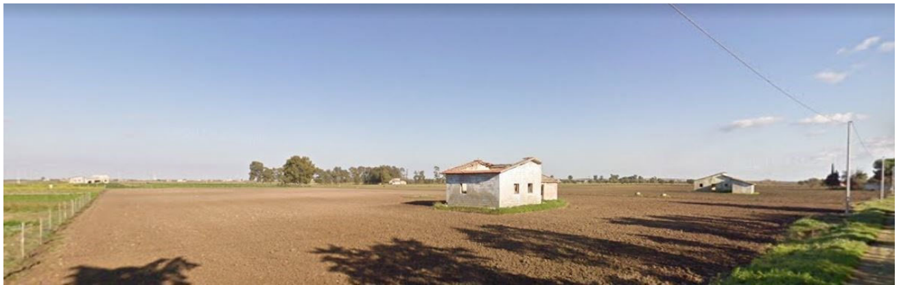
Fig. 17– Area aerogeneratore F8– situazione reale (foto da sud-ovest)
