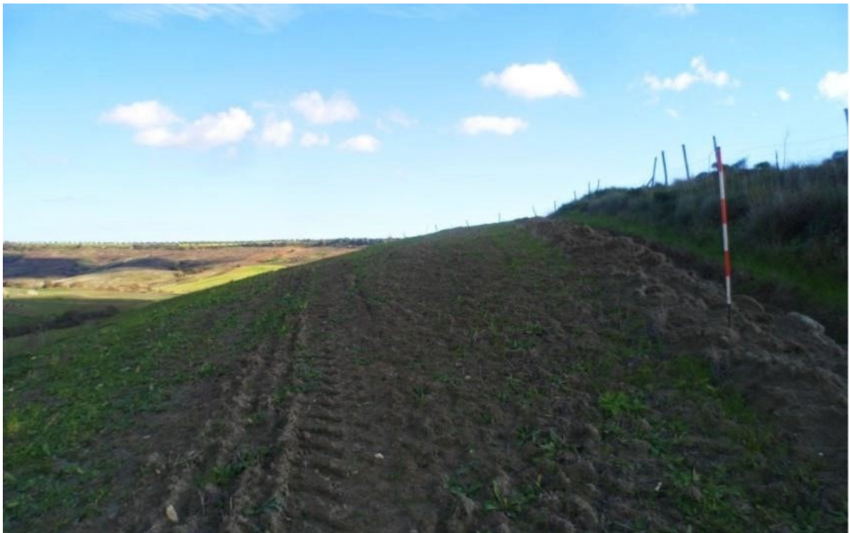
fig. 3 – Area aerogeneratore F1 e punto di installazione – situazione reale (foto da est)
