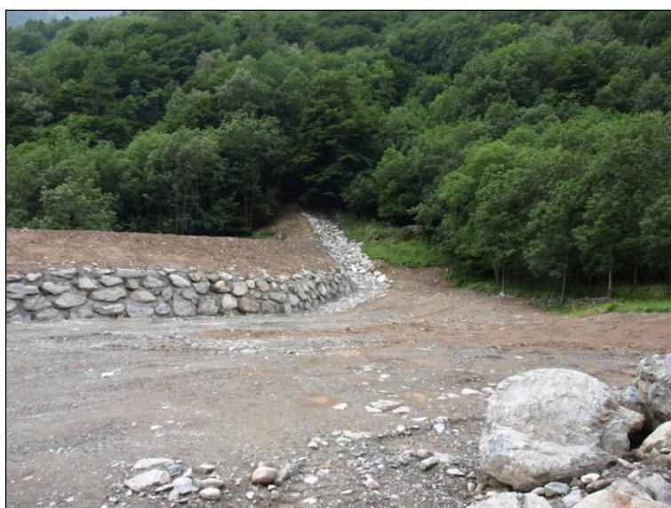
*Figura 34 –Scogliera lungo la parte terminale di un'incisione laterale destra.*
