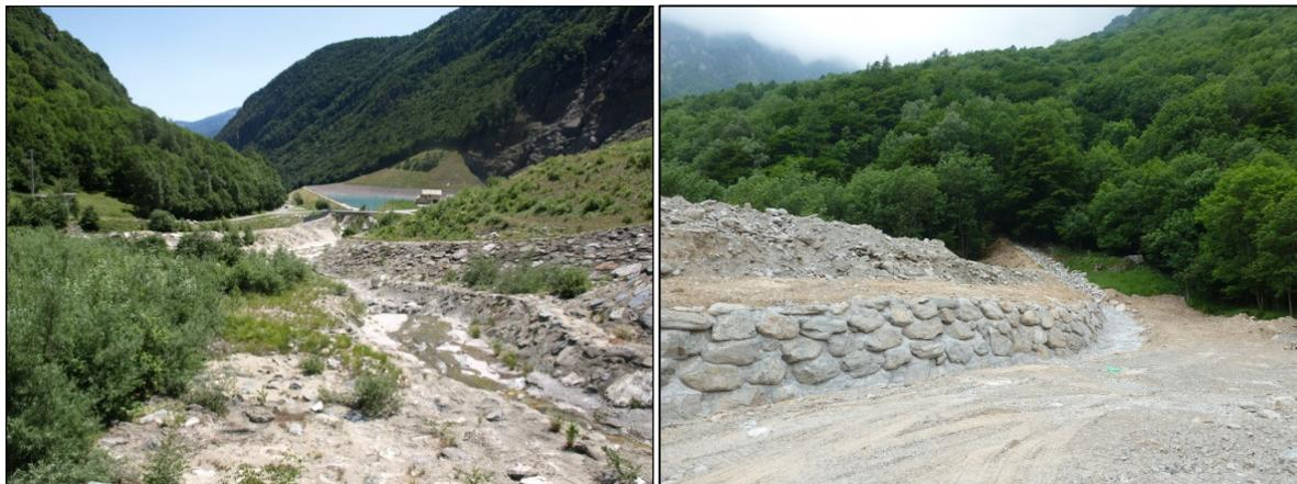
*Figura 11–Interventi di sistemazione idraulica del Torrente Clarea: difese di sponda in corrispondenza dell'immissione del RioTiraculo (foto a sinistra, vista dal Tiraculo verso valle); vallo a monte della colonia, in destra Clarea (foto a destra)*
