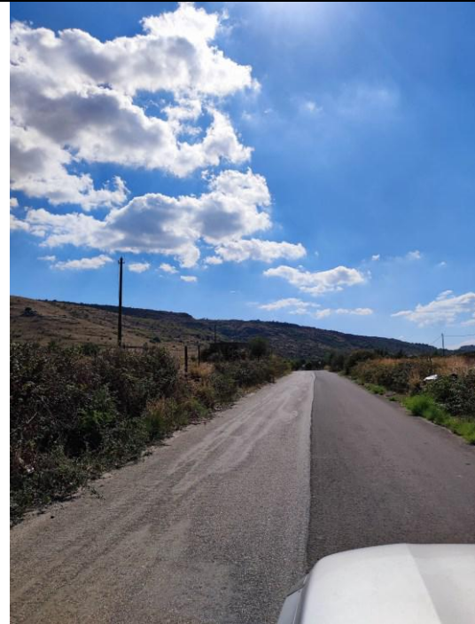
SP 10 in prossimità del tratto su suolo agricolo
