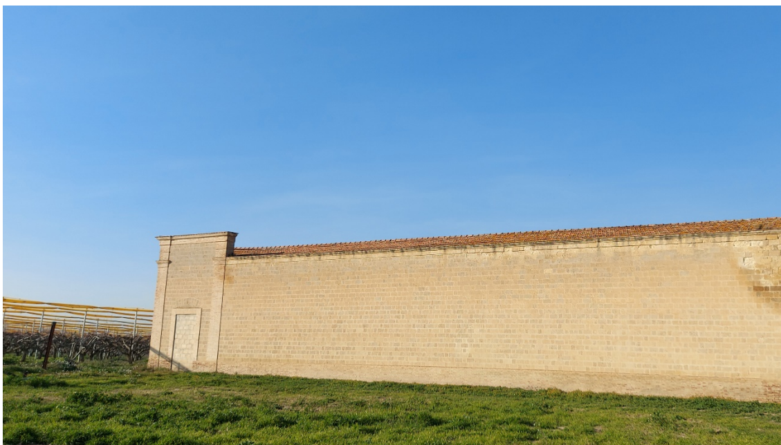
Stato di fatto – Punto di presa fotografica 4A
