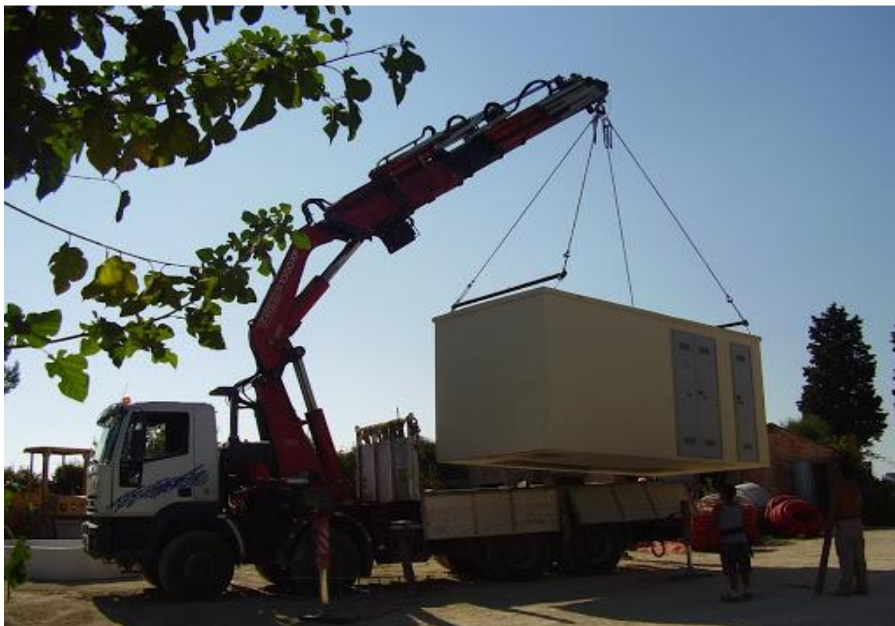
Figura 2 - Smontaggio e rimozione cabine di campo
