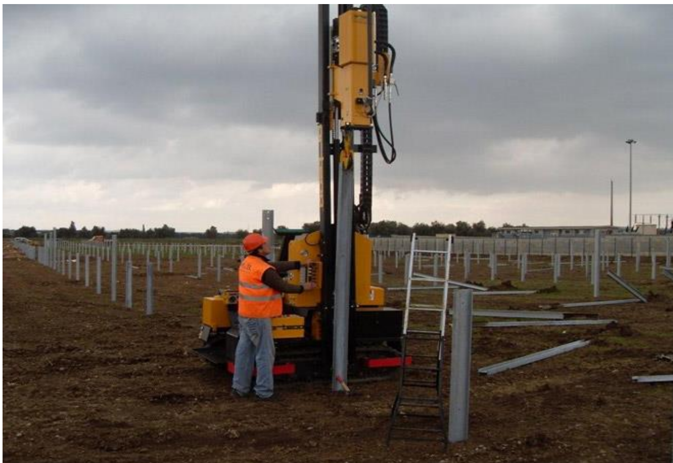
Figura 1 - Rimozione palo con macchina operatrice
