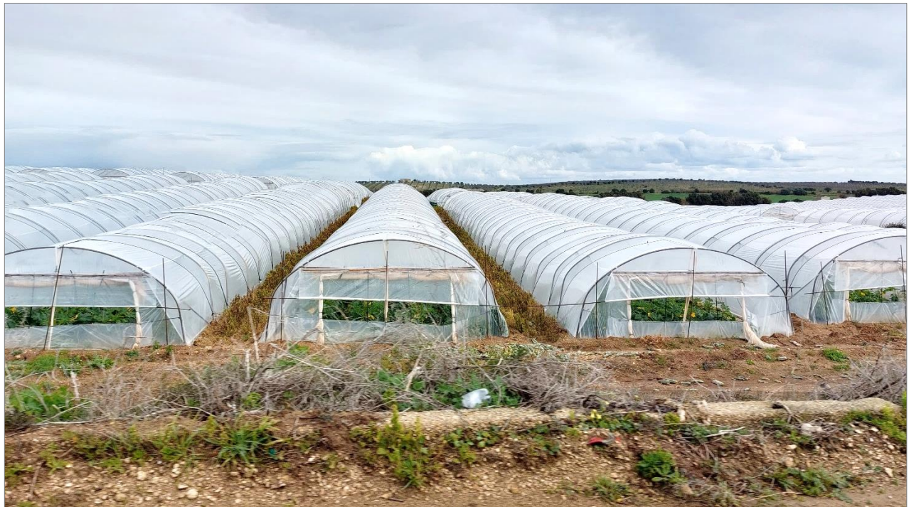
Foto 1 - Area impianto agrovoltico - Lotto 1 - STATO DI FATTO
