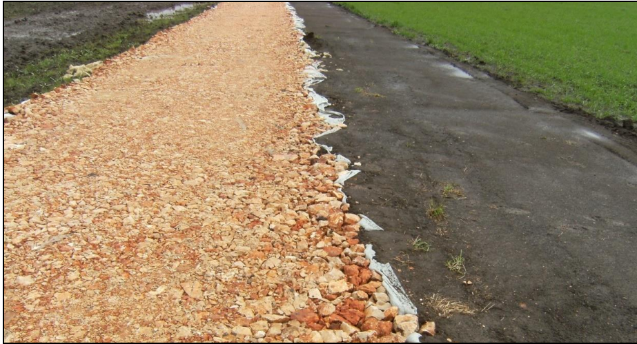
Figura 2. 6 Dettaglio pacchetto stradale con geotessuto
