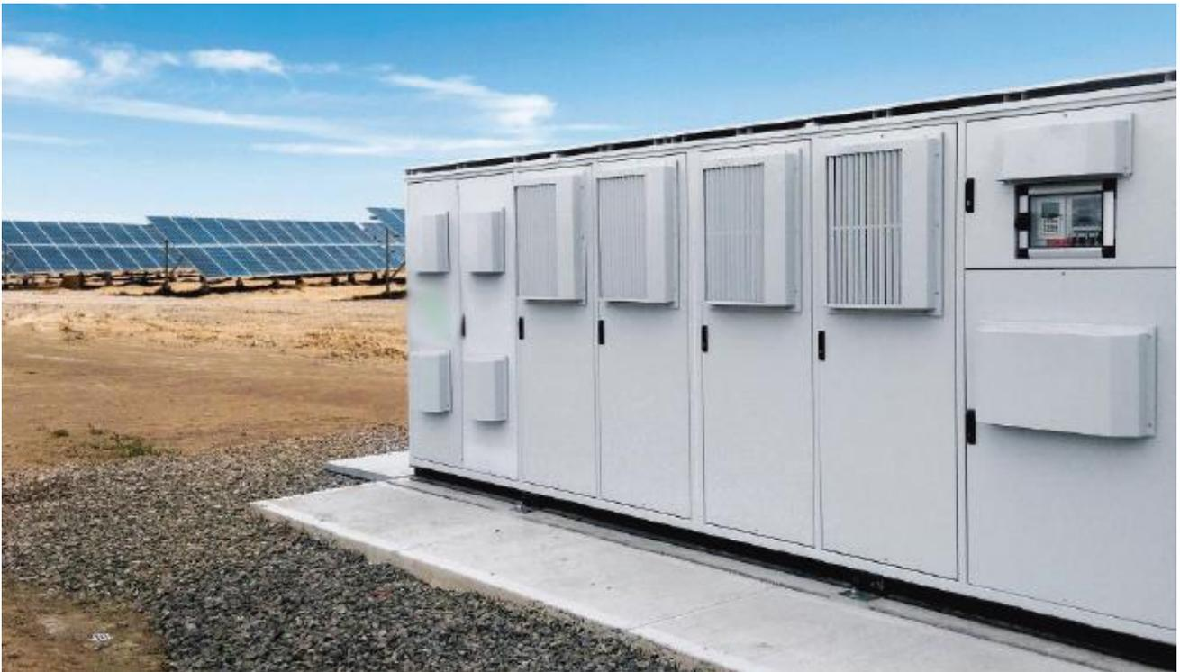
Un sistema di accumulo (c.d. Storage) è un sistema caratterizzato da un insieme di dispositivi, apparecchiature e logiche di gestione e controllo, funzionale ad assorbire e rilasciare energia elettrica. Tale sistema deve essere in grado di operare in maniera continuativa e in parallelo con la rete.
