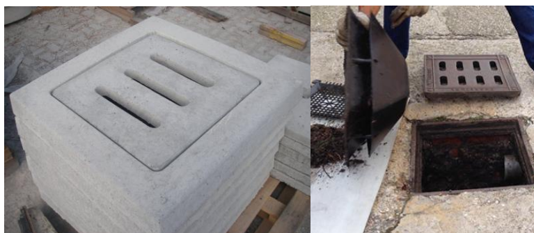
Figura 5. 2 Pozzetti di grigliatura
