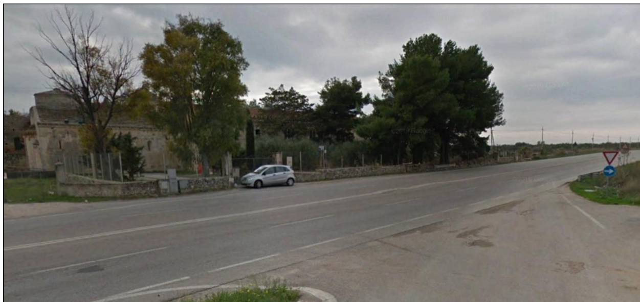
Foto 6 - Ante e post operam: ripresa fotografica dell'impianto dal punto PV5 di coordinate 567820.64 E; 4605387.39 N; l'impianto agrolvoltaico risulta non visibile.
