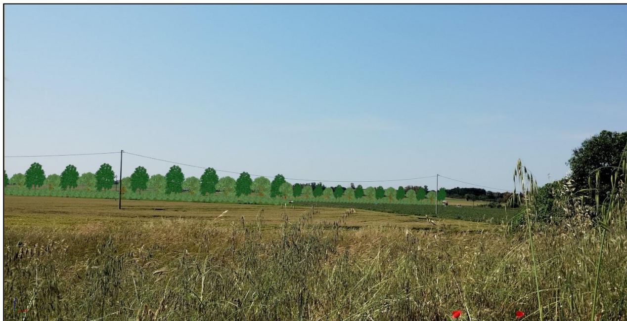
Foto 5 - Ante Operam: ripresa fotografica dell'impianto dal punto PV1 di coordinate 561953.28 E; 4601899.15 N; l'impianto risulta visibile
