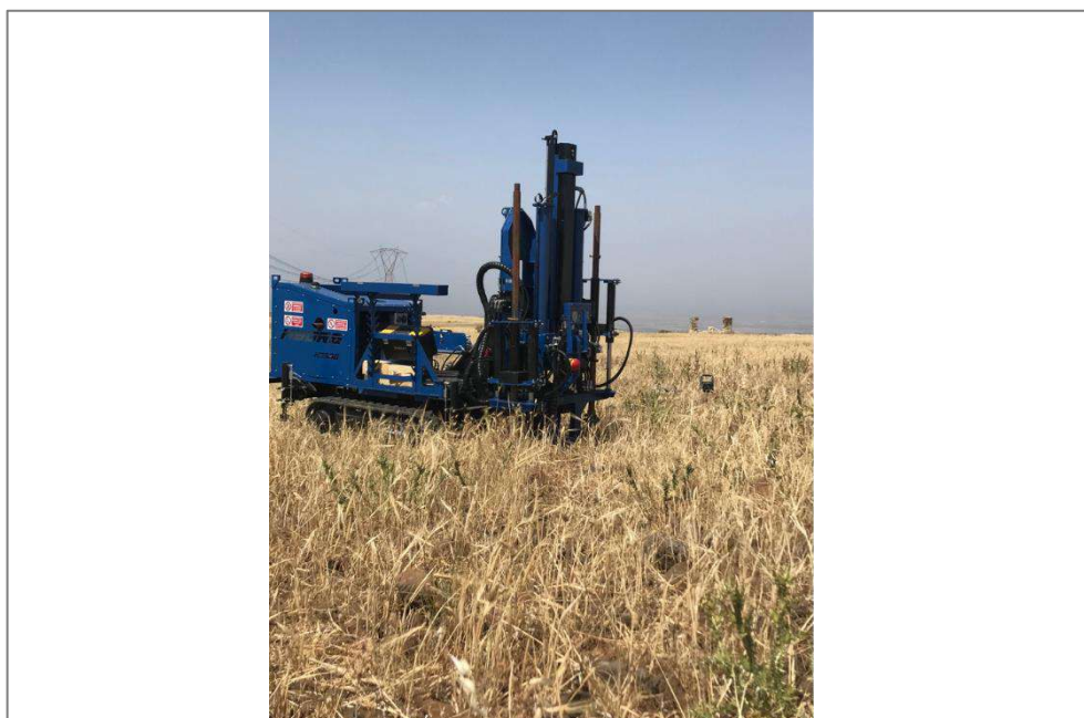
Preparazione foro per prove di permeabilità a carico variabile – SITO 1
