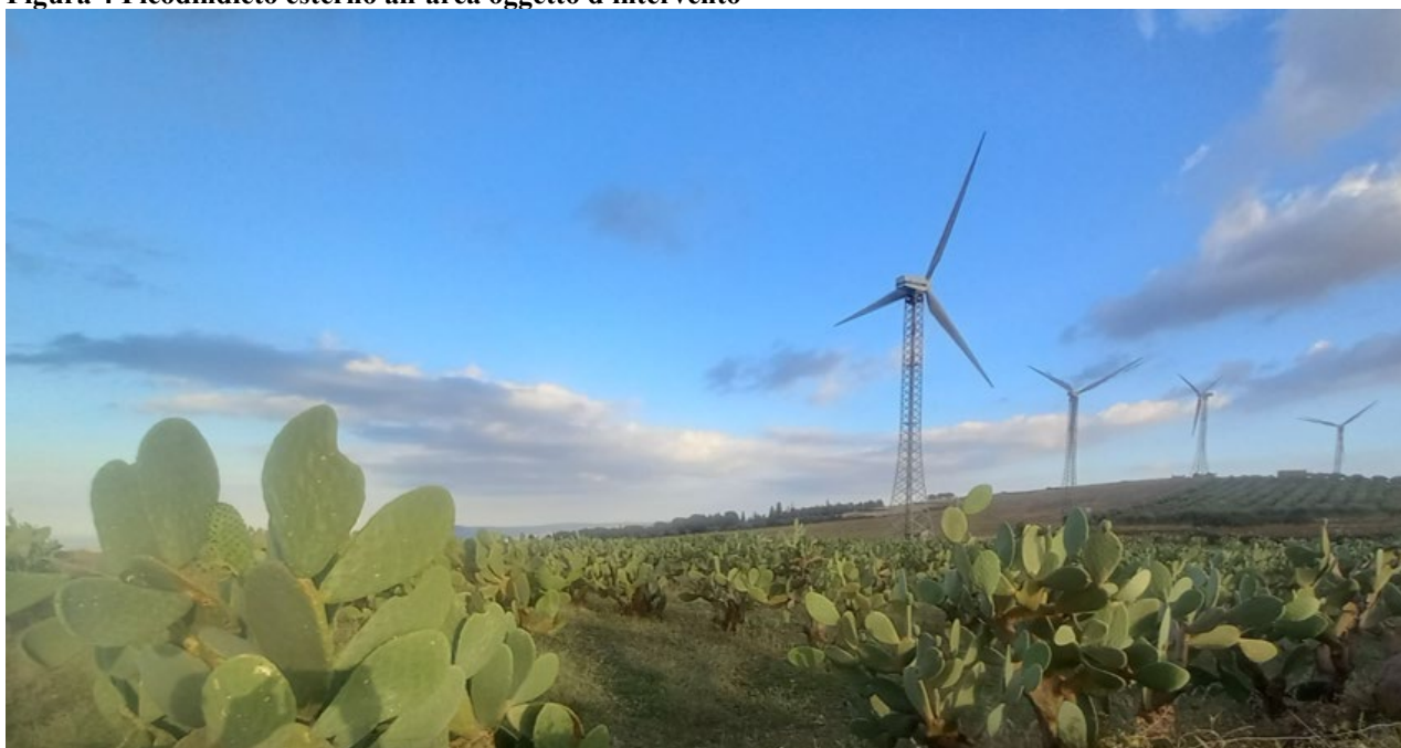
Figura 4 Ficotindieto esterno all'area oggetto d'intervento
