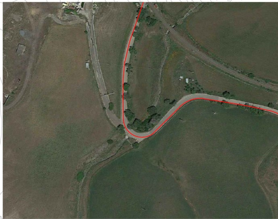
Parallelismo su ponte esistente SP 28/II km 8+65
