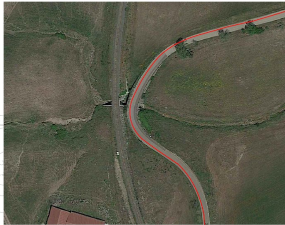
Parallelismo su ponte esistente SP 28/II km 8+40
