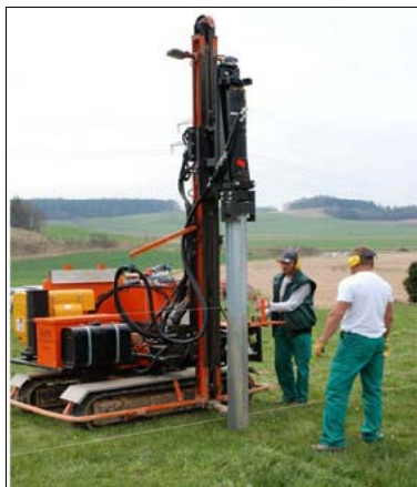
Fig. 12 - Pali di fondazione "retrofit"
