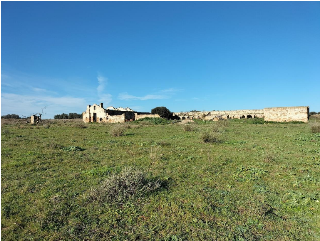
Figura 30: Rudere visto dal punto foto 3, interno all'impianto
