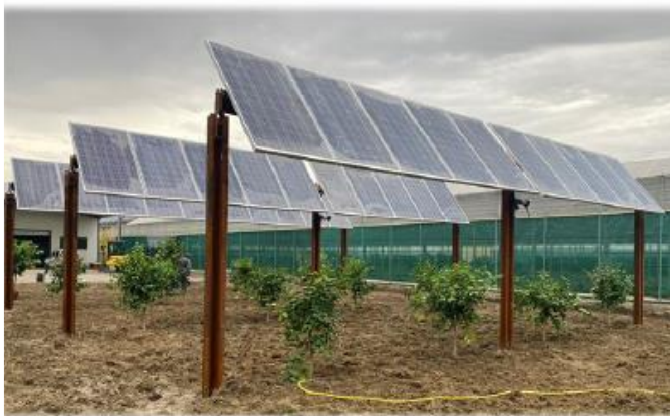
Figura 2: Tracker per agro-fotovoltaico
