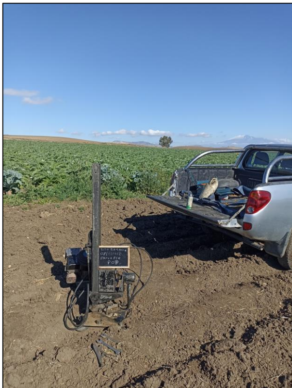
(Foto n° 8 – Prova penetrometrica - Din_08)
