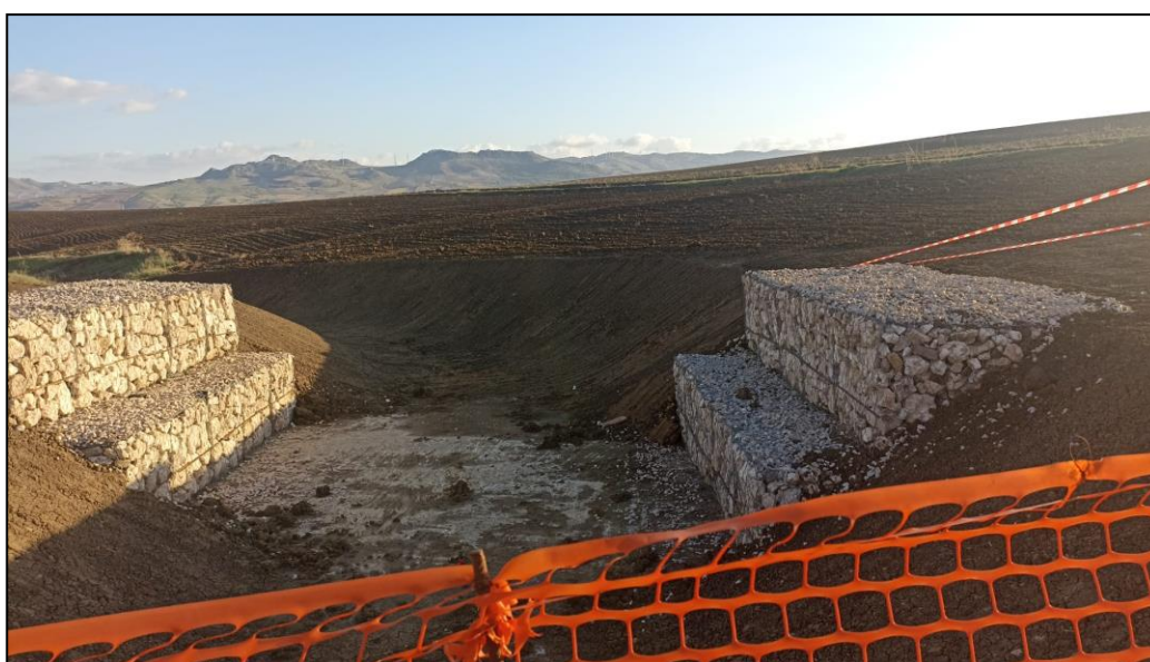
Figura 5.2.5 – Sistemazione con gabbionata lungo la linea di impluvio principale
