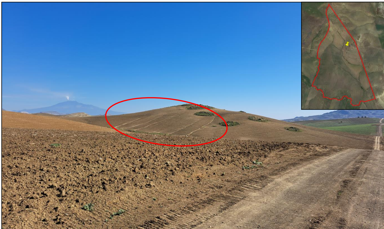
Figura 5.2.1 – Panoramica area blocco A con presenza di solchi erosivi effimeri (sheet erosion)
