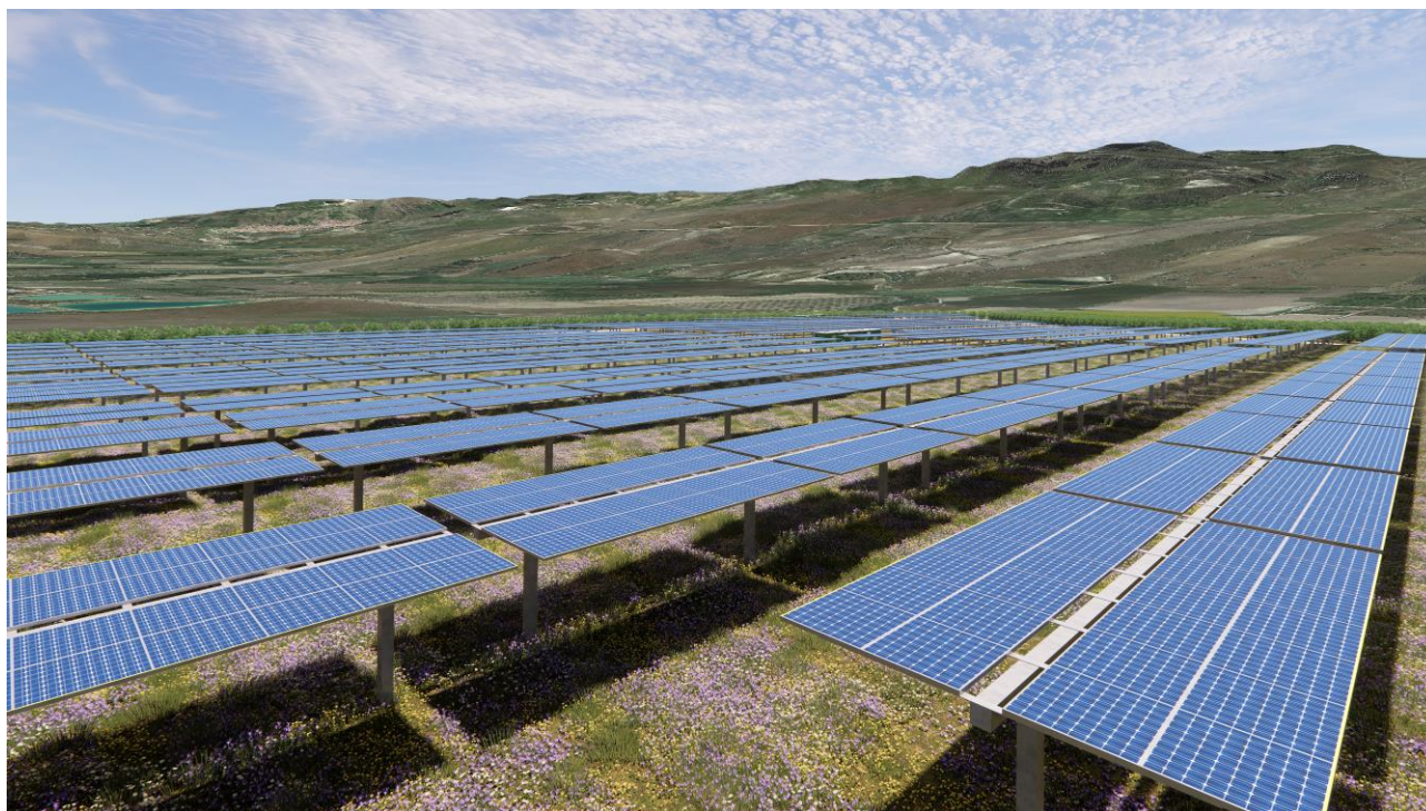
Figura 1 – Vista interna impianto
