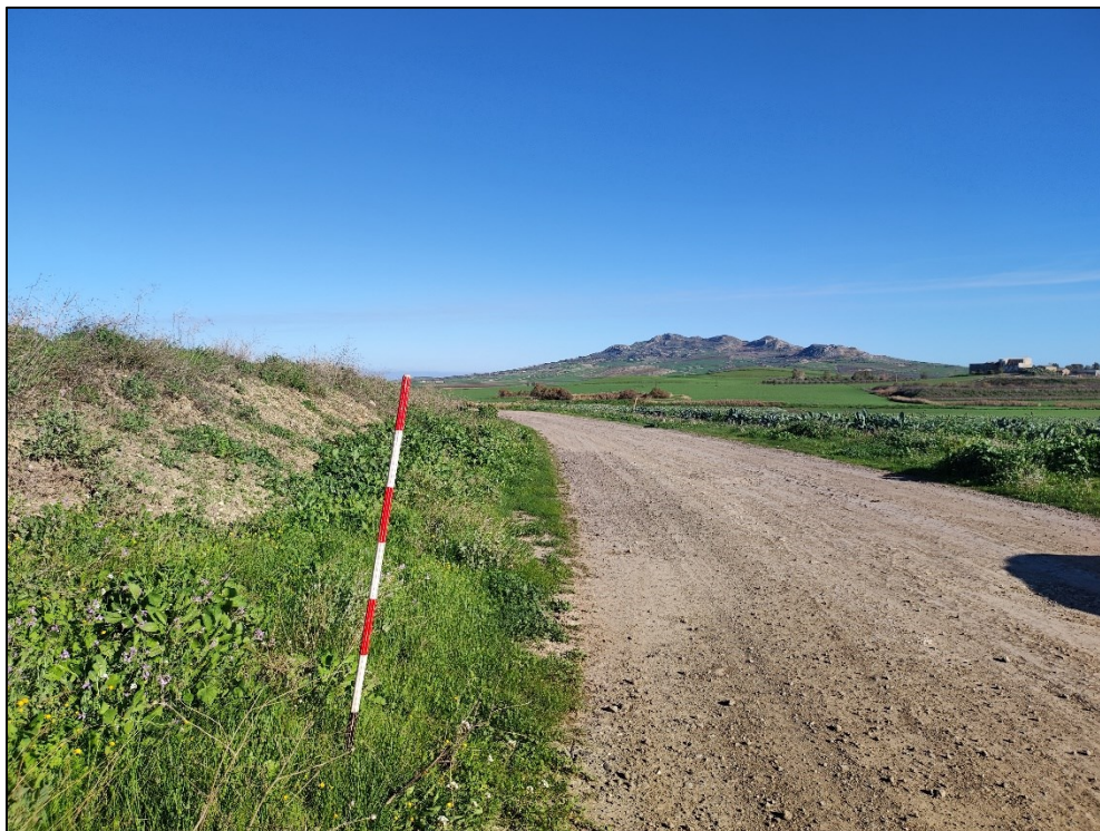
Fig. 17: SP 103 in corrispondenza dei Blocchi B e C
