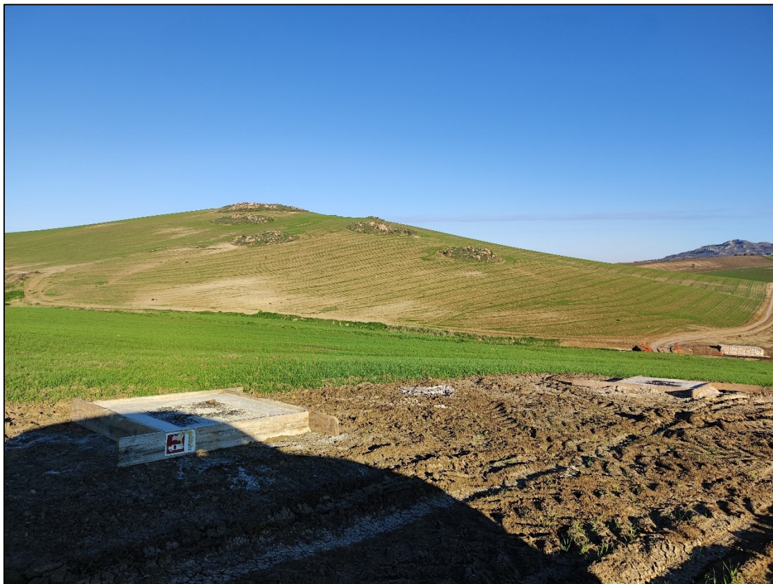
Fig. 19: lavori in corrispondenza de Blocco A (cavidotto di altro progetto)
