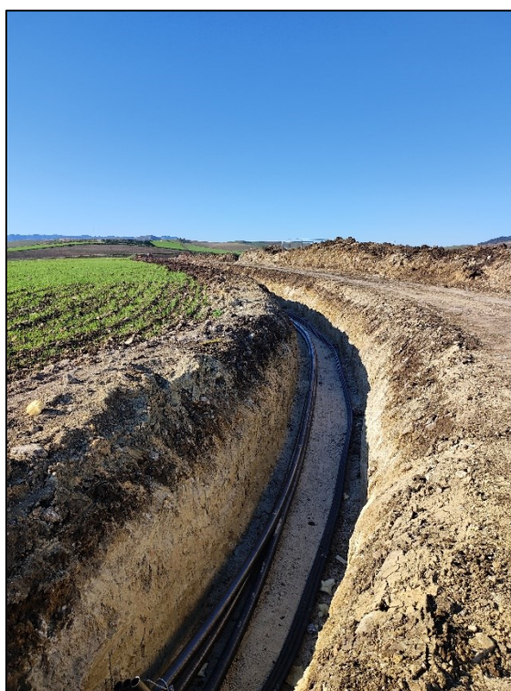
Fig. 16: strada interpodereale presso la SP 103 con lavori in corso
