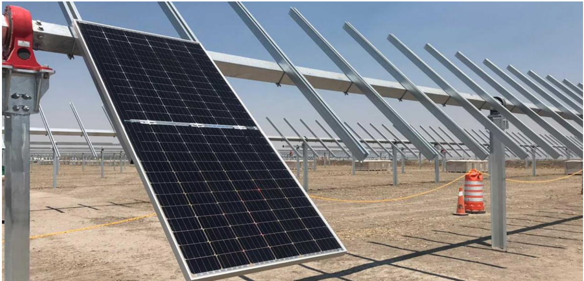
Figura 58 - Montaggio tracker
