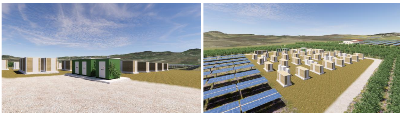
Figure 13-14 – Particolari impianto agrivoltaico: cabine di trasformazione e sistema BESS
