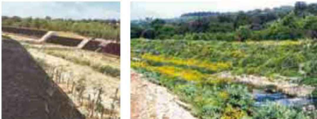
Figura 7 - Sponde di una fiumara rivestite con geostuoia tridimensionale rinforzata erinverdita.
