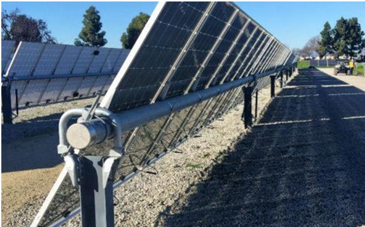
Il termine che indica la capacità della cella fotovoltaica di sfruttare la luce sia frontalmente che posteriormente viene definito, appunto, “bifaccialità”: un fenomeno reso possibile, in fisica, dal cosiddetto Fattore di Albedo della superficie su cui i moduli vengono installati. L’albedo è l’unità di misura che indica la capacità riflettente di un oggetto o di una superficie. Solitamente viene espressa con un valore da 0 a 1, che può variare a seconda dei singoli casi.
