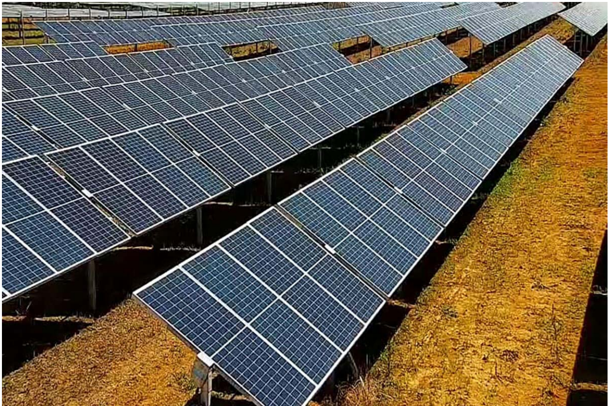
FIGURA 10 – INSTALLAZIONE SU INSEGUITORE MONO ASSIALE CON DOPPIO MODULO
