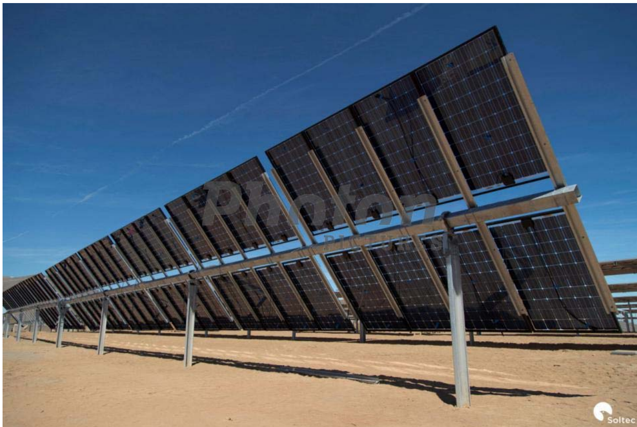
FIGURA 9: CAMPO CON DOPPIO MODULO IN VERTICALE SU INSEGUITORE
