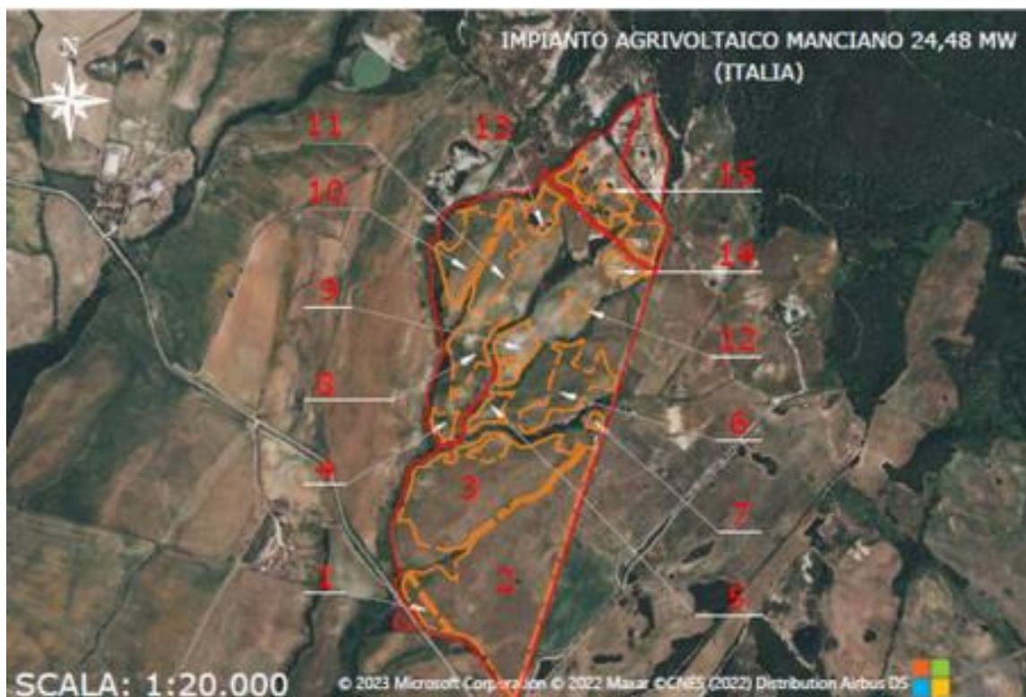
Fig. 6 – Ortofoto con ubicazione dell'area di impianto
