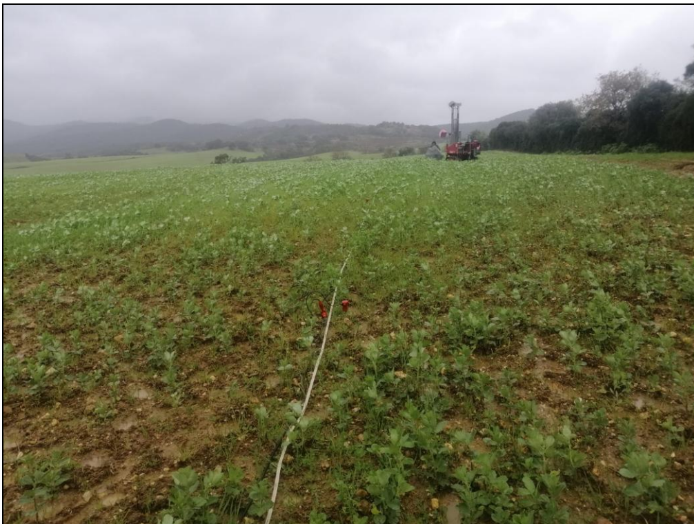
Esecuzione profilo sismico a rifrazione 1-1'
