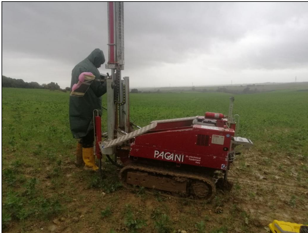
Esecuzione prova penetrometrica dinamica continua – DPSH 5
