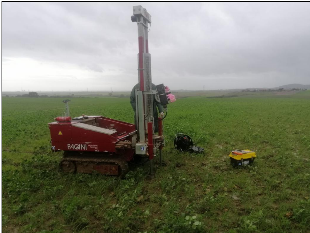
Esecuzione prova penetrometrica dinamica continua – DPSH 3
