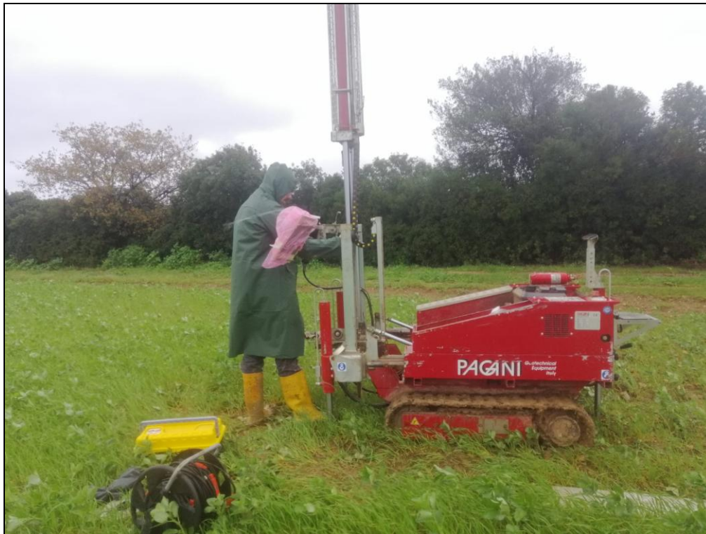
Esecuzione prova penetrometrica dinamica continua – DPSH 1
