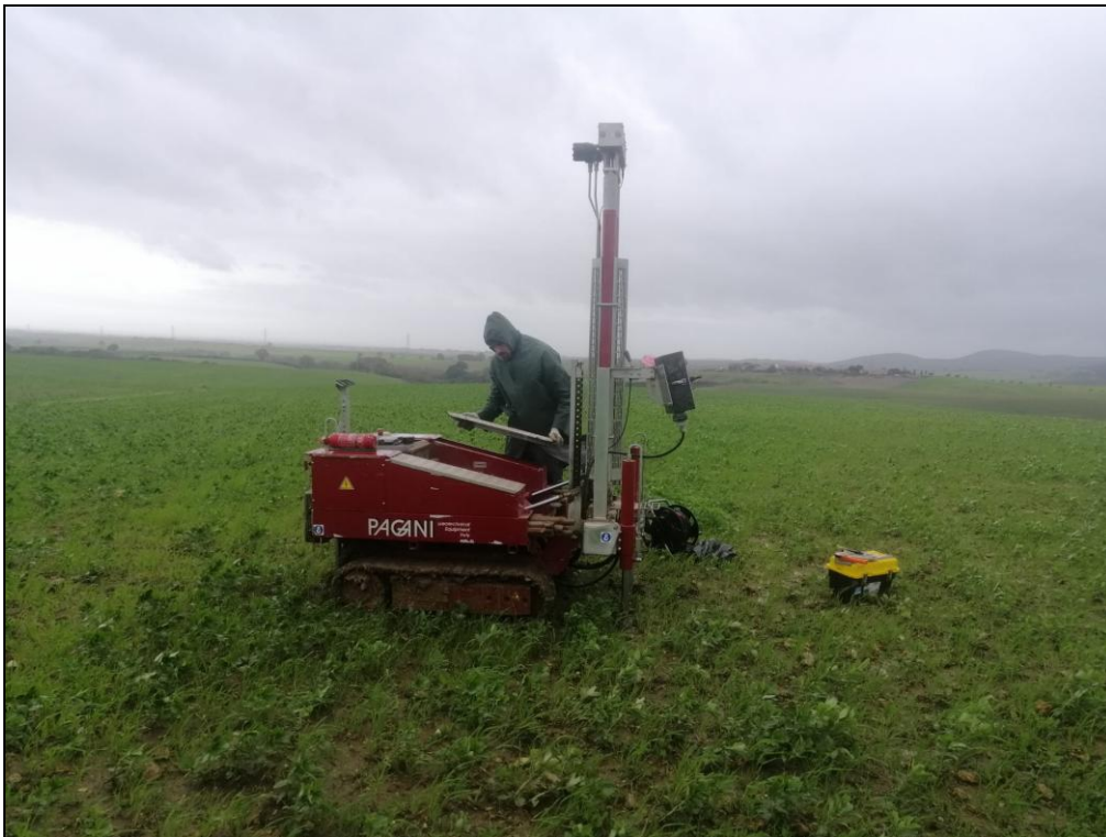
Esecuzione prova penetrometrica dinamica continua – DPSH 2
