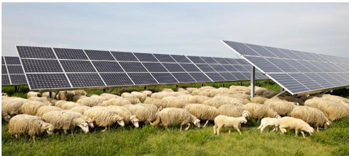
Fig. 5 – Esempio di agrivoltaico
