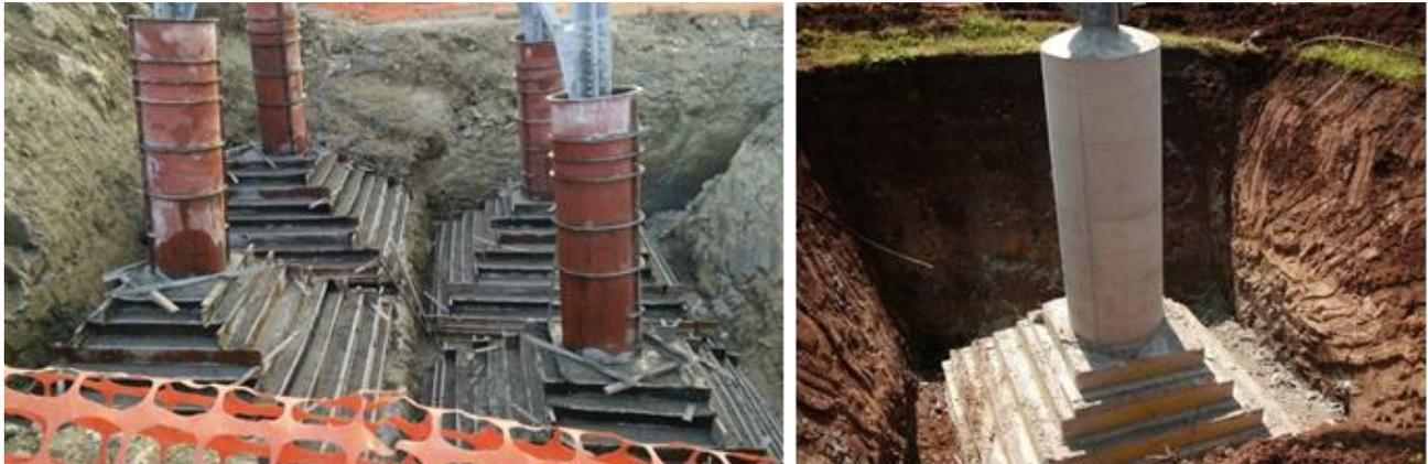
**Figura 27– Realizzazione di fondazioni superficiali tipo CR per un sostegno a traliccio. Particolare di una fondazione durante la fase di cassetatura (a sinistra) e al termine della stessa (a destra), dove si possono distinguere facilmente la parte inferiore a parallelepipedi tronco piramidali ed il colonnino di raccordo con la “base” del sostegno.**
