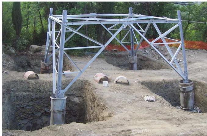
**Figura 28– Realizzazione di fondazioni superficiali tipo CR per un sostegno a traliccio. Nell’immagine si possono osservare le quattro buche, la base del sostegno collegata alla fondazione tramite i “monconi” ed i casseri utilizzati per i quattro “colonnini”.**
