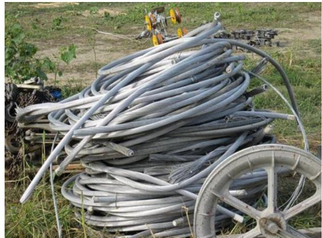
**Figura 31: - Fasi demolizione di un sostegno a traliccio, particolare di materiale raccolto**
