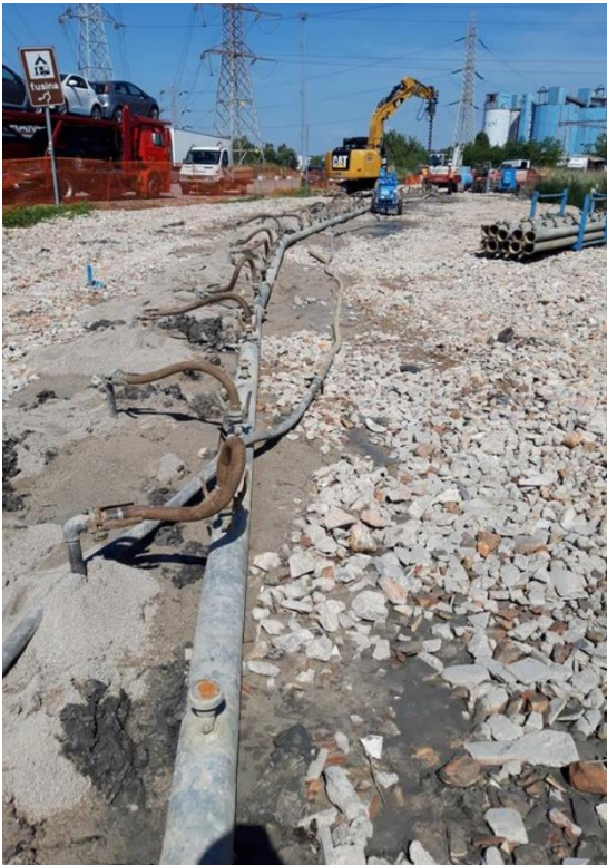
Figura 17: Esempio di impianto wellpoint
