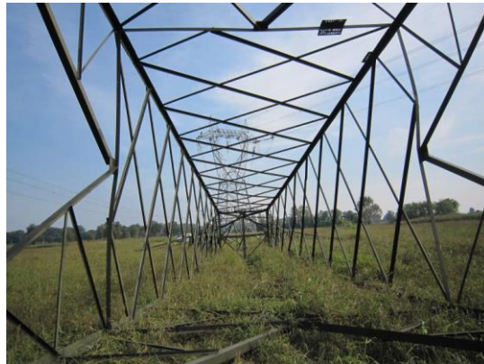
Figura 15: Fasi demolizione di un sostegno a traliccio
