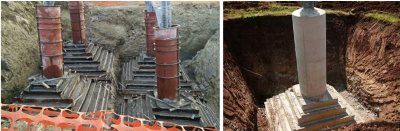
Figura 12– Realizzazione di fondazioni superficiali tipo CR per un sostegno a traliccio. Particolare di una fondazione durante la fase di cassetteratura (a sinistra) e al termine della stessa (a destra), dove si possono distinguere facilmente la parte inferiore a parallelepipedi tronco piramidali ed il colonnino di raccordo con la “base” del sostegno.
