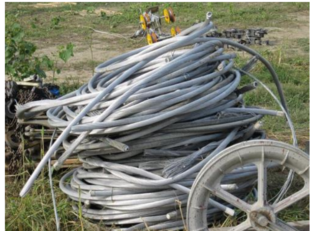
Figura 16: - Fasi demolizione di un sostegno a traliccio, particolare di materiale raccolto
