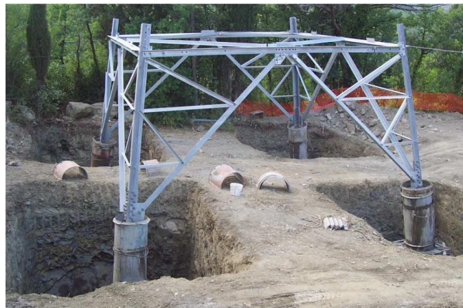
Figura 13– Realizzazione di fondazioni superficiali tipo CR per un sostegno a traliccio. Nell’immagine si possono osservare le quattro buche, la base del sostegno collegata alla fondazione tramite i “monconi” ed i casseri utilizzati per i quattro “colonnini”.
