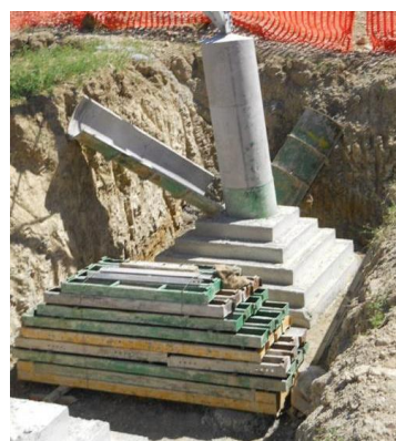
Figura 3: Realizzazione di fondazioni superficiali tipo CR per un sostegno a traliccio. Nell'immagine si può osservare una fondazione CR appena "scasserata". Si possono distinguere facilmente la parte inferiore a parallelepipedi tronco piramidali ed il colonnino di raccordo con la "base" del sostegno
