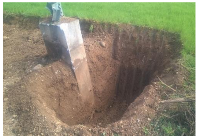
Figura 11: - Esempio di rimozione fondazione superficiale di un sostegno 220 kV (a sx) e 380 kV ST (a dx).
