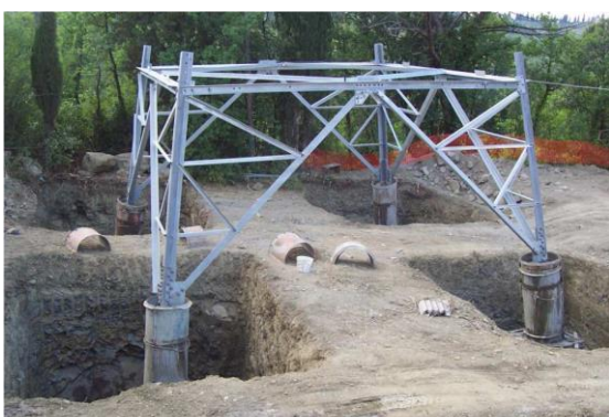
Figura 2: Realizzazione di fondazioni superficiali tipo CR per un sostegno a traliccio. Nell'immagine si possono osservare le quattro buche, la base del sostegno collegata alla fondazione tramite i "monconi" ed i casseri utilizzati per i quattro "colonnini"
