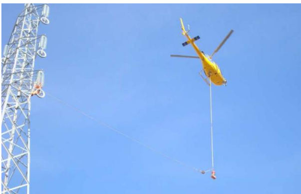
Figura 7: Utilizzo dell'elicottero per la stesura della fune pilota
