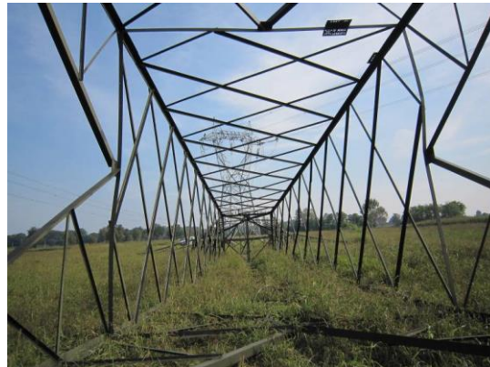
Figura 9: Fasi demolizione di un sostegno a traliccio
