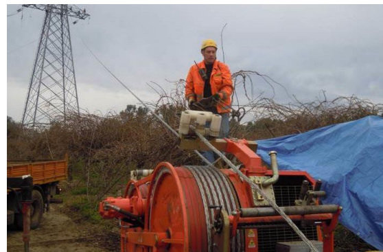
Figura 8: Fasi di tesatura della linea elettrica
