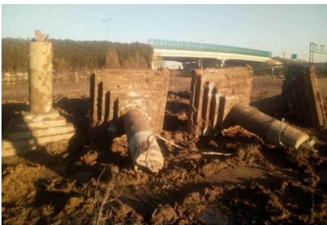
Figura 11: - Esempio di rimozione fondazione superficiale di un sostegno 220 kV (a sx) e 380 kV ST (a dx).
