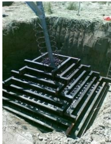
Figura 4: Esempio di realizzazione di una fondazione a plinto con riseghe. Nell'immagine di sinistra si può osservare un disegno di progetto mentre nell'immagine di destra la fase di casseratura della fondazione
