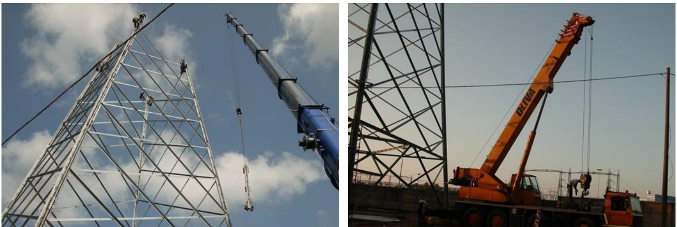
Figura 6: Fasi di montaggio sostegno a traliccio
