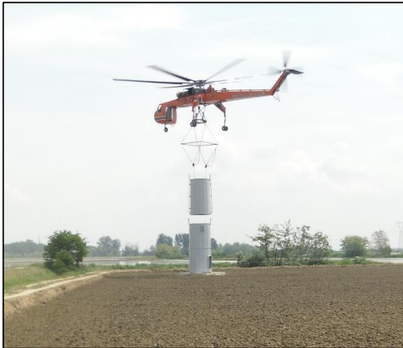
Figura 31: Elicottero durante le operazioni di posa della parte aerea del sostegno
