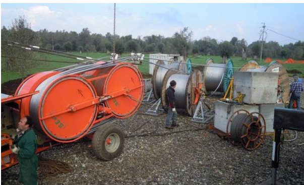
Figura 8: Fasi di tesatura della linea elettrica
