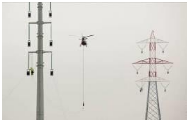
Figura 7: Utilizzo dell'elicottero per la stesura della fune pilota
