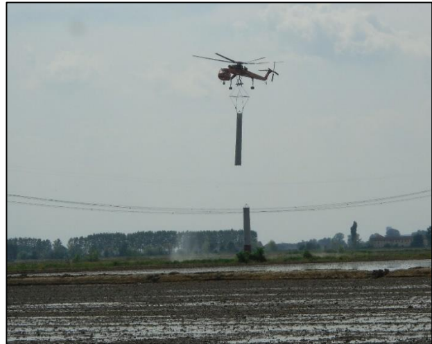
Figura 31: Elicottero durante le operazioni di posa della parte aerea del sostegno
