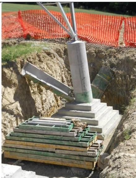
Realizzazione di fondazioni superficiali tipo CR per un sostegno a traliccio. Nell'immagine si può osservare una fondazione CR appena "scasserata". Si possono distinguere facilmente la parte inferiore a parallelepipedo tronco piramidale ed il colonnino di raccordo con la "base" del sostegno
