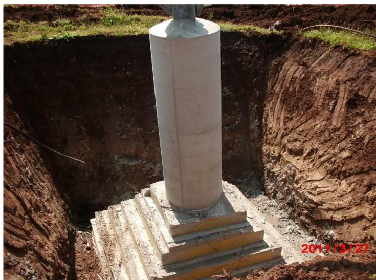
*Esempio di realizzazione di una fondazione a plinto con riseghe tipo CR. Nell'immagine in alto a sinistra di può osservare un disegno di progetto mentre nell'immagine in alto a destra la fase di cassetatura della fondazione.*
