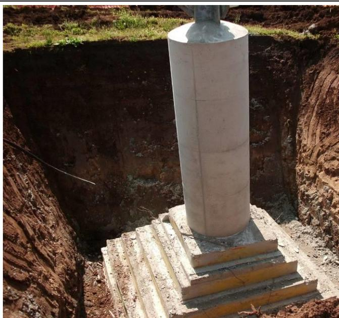
Realizzazione di fondazioni superficiali tipo CR per un sostegno a traliccio. Nell'immagine si può osservare una fondazione CR appena "scasserata". Si possono distinguere facilmente la parte inferiore a parallelepipedo tronco piramidale ed il colonnino di raccordo con la "base" del sostegno.
