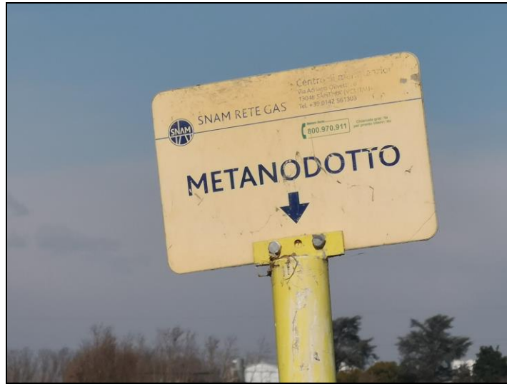
Foto dettaglio palina segnalazione metanodotto
