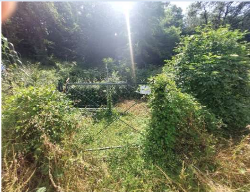
Foto 5 | Interferenza con impianto a servizio acquedotto
