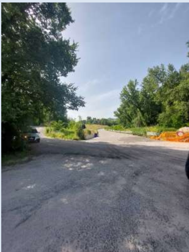
Foto 4 | Tratto ANAS esistente in direzioni Sud
