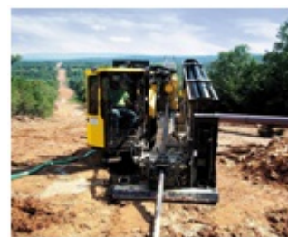
PERFORAZIONI MEDIANTE LA NO-DIG
