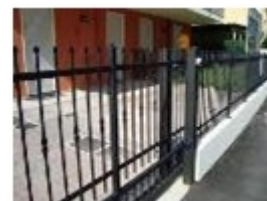
RECINZIONE E OPERE IN FERRO
