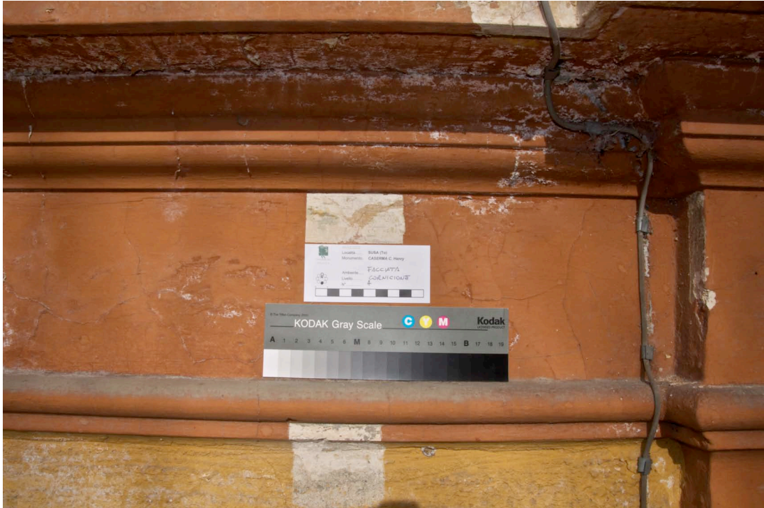
Localizzazione dei sondaggi eseguiti sul cornicione
