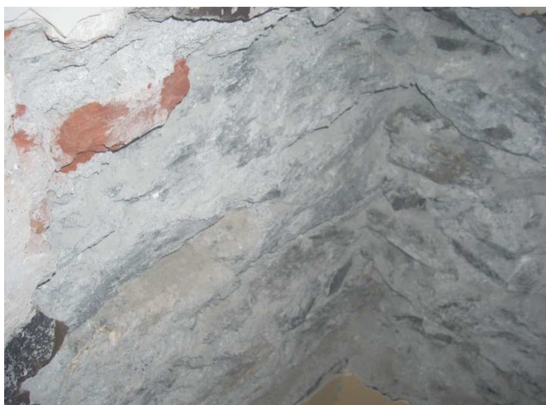
Immorsatura muratura portante
