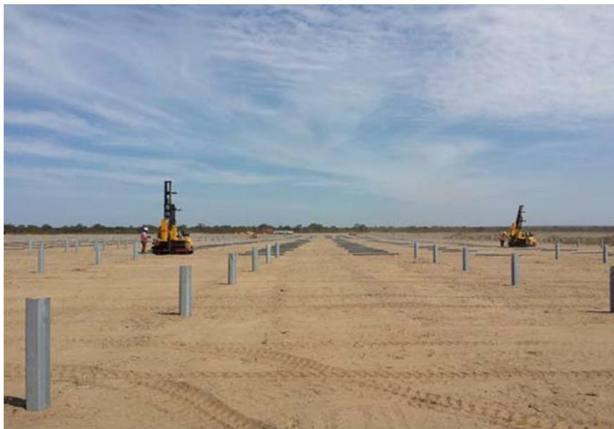
L'infissione dei profili di palificazione nel terreno con battipali idraulici è particolarmente indicata soprattutto in caso di impianti di grandi dimensioni; con una macchina si può realizzare, a seconda del terreno, una potenza di circa 250 pali al giorno. Sono possibili anche forme di terreno più difficili (pietre ecc.); in caso di sottosuoli in roccia, la macchina può essere attrezzata aggiuntivamente con un gruppo di foratura. Il montaggio è possibile anche su pendii.
