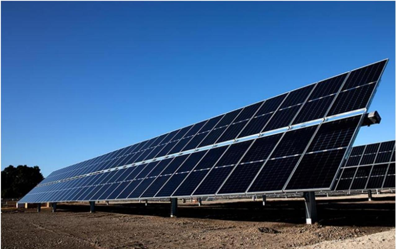
**Figura 4-5 – Tipico tracker fotovoltaico in configurazione "2-Portrait"**
