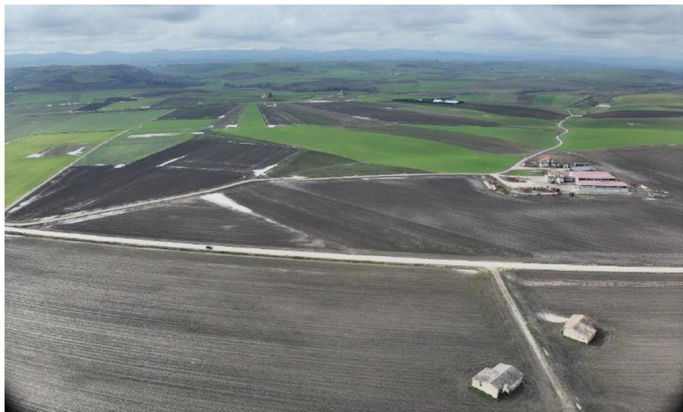
Punto di Presa 2
