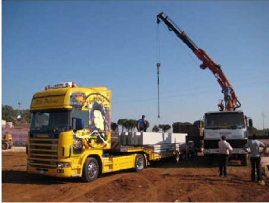
Figura 25 | Attività di scarico cabina di campo
