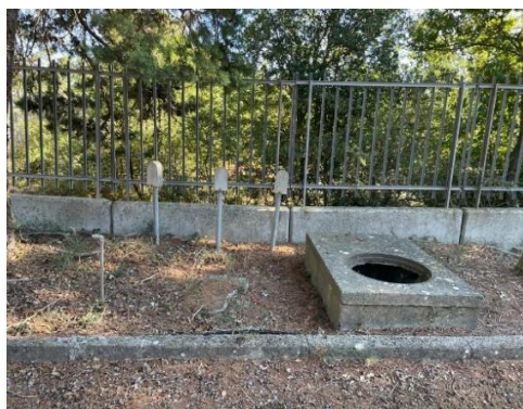
Figura 8 – Punti di monitoraggio rinvenuti in sede di sopralluogo sul serbatoio SS1
