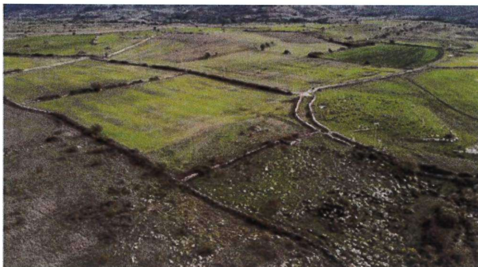
FIGURA 11 - FOTO AREA OGGETTO DI STUDIO.
