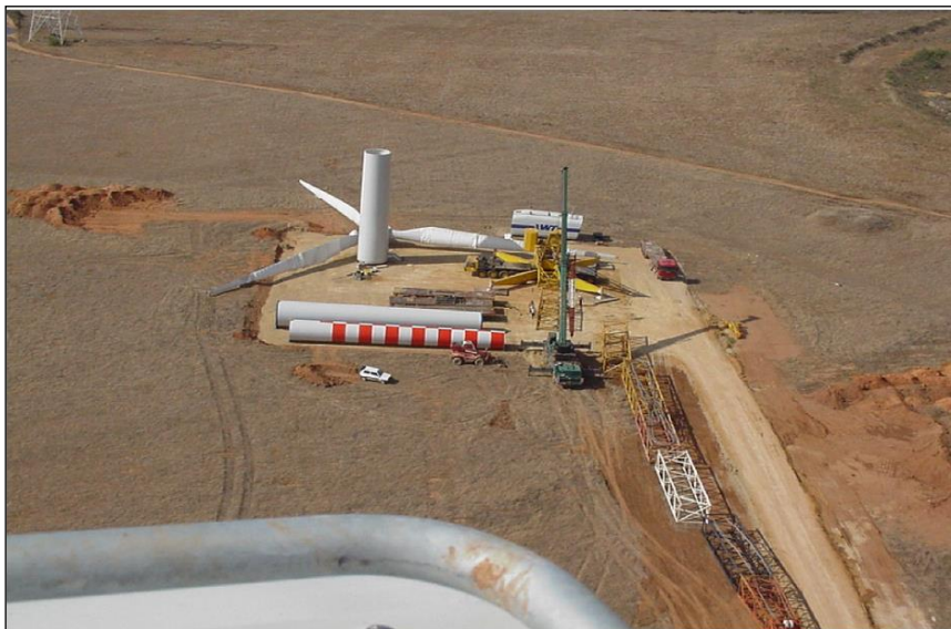
Foto 1. Piazzola per il montaggio dell'aerogeneratore
