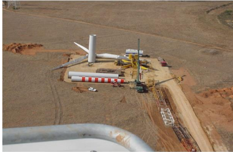
Figura 38 – Piazzola per il montaggio dell'aerogeneratore
