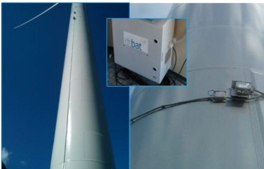
Figura 13 – Esempio di installazione di un sistema automatico su aerogeneratore per abbassare il rischio collisione
