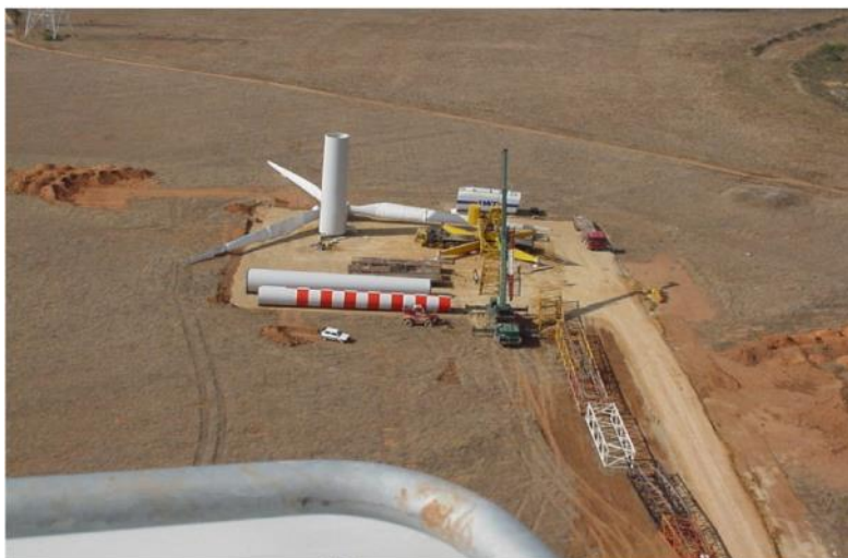
Figura 4 – Piazzola per il montaggio dell'aerogeneratore
