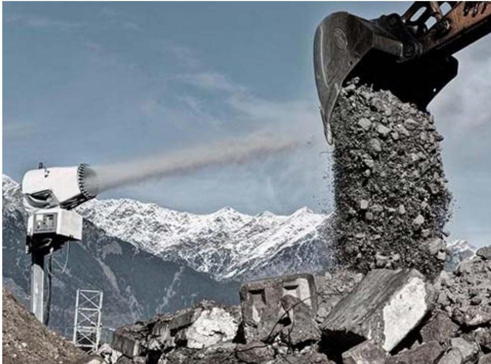
Figura 85 - Cannone nebulizzatore polveri di cantiere
