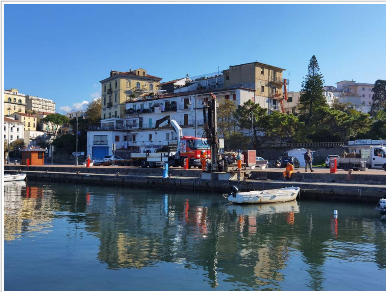
Ubicazione Sondaggio S3
